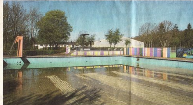
Das Nichtschwimmerbecken ist noch nicht mit Wasser gefüllt.
